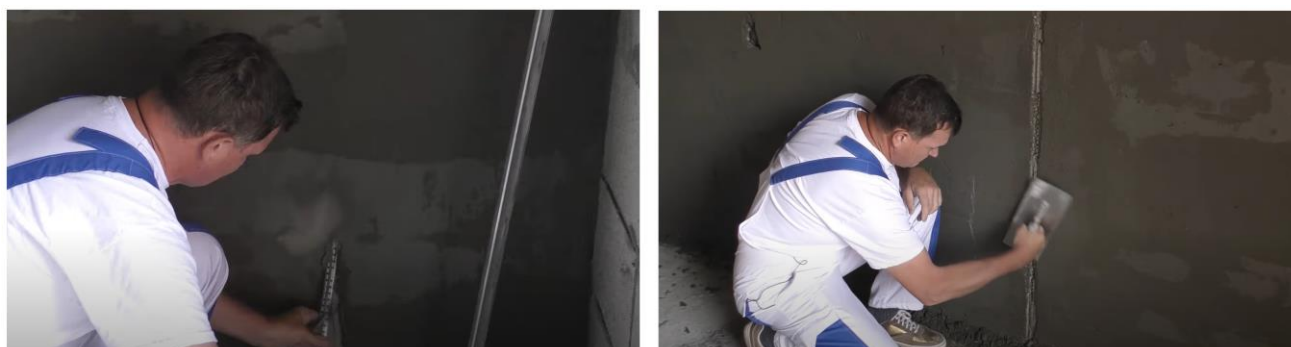
Рис. 20. Схема демонтажа маяков и заделки образовавшихся борозд
